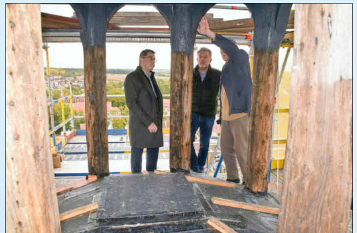
Architekt Karlheinz Lieberger (rechts) erläuterte Bürgermeister Wolfgang Lampe (links) und seinem Stellvertreter Hermann Schuch die Sanierungsarbeiten in der Laterne des Turms.
