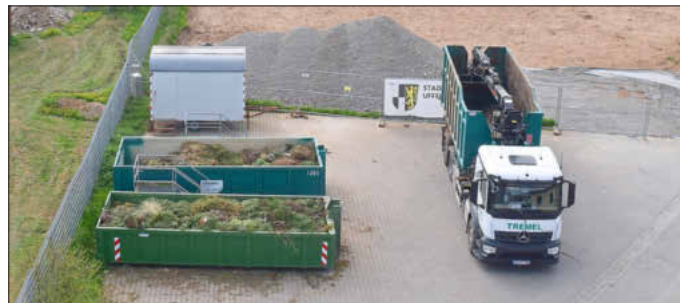
Während der Bauarbeiten für den neuen Bauhof werden die Grüngutcontainer vom Platz bei der Kläranlage in die Wiesenstraße versetzt. Foto: Gerhard Krämer
