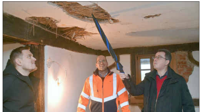
Im Inneren des Torturms stehen die Putz- und Malerarbeiten bevor. Bürgermeister Wolfgang Lampe (rechts) prüft im Beisein von Viktor Scheider (links) und Jürgen Hofmann die Stabilität der alten Decke mit seinem Schirm. Fotos: Gerhard Krämer
