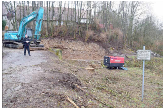
Die Grube für die neue Kleinkläranlage ist ausgehoben. Bürgermeister Wolfgang Lampe schaute sich vor Ort um.
