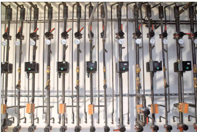
Zum Glück gibt es Menschen, die sich im Rohrleitungsnetz auskennen.
