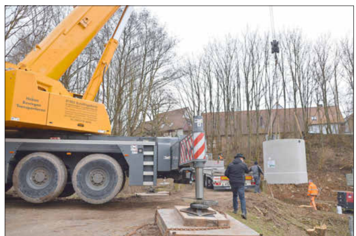
Ein Kran ließ das 12,5 Tonnen schwere Fertigteil einschweben.
