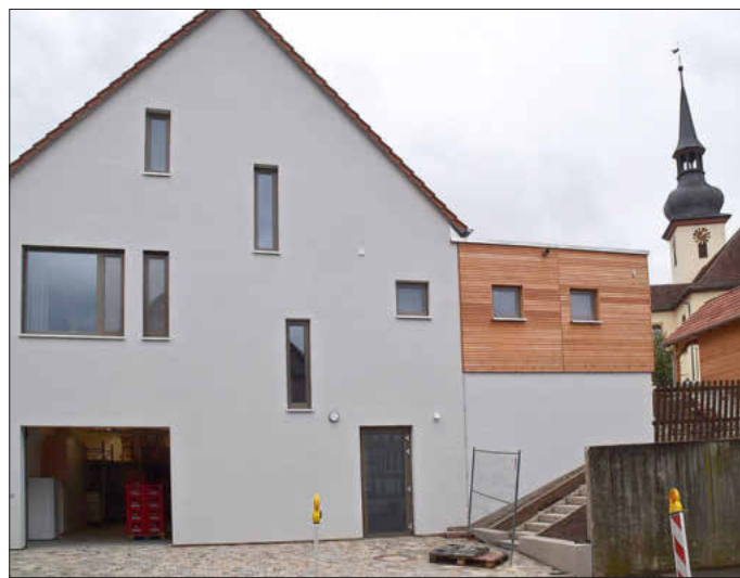
Das Dorfgemeinschaftshaus Welbhausen ist fertig. Das Bild zeigt die Ansicht von der Hauptstraße aus. Fotos: Gerhard Krämer
