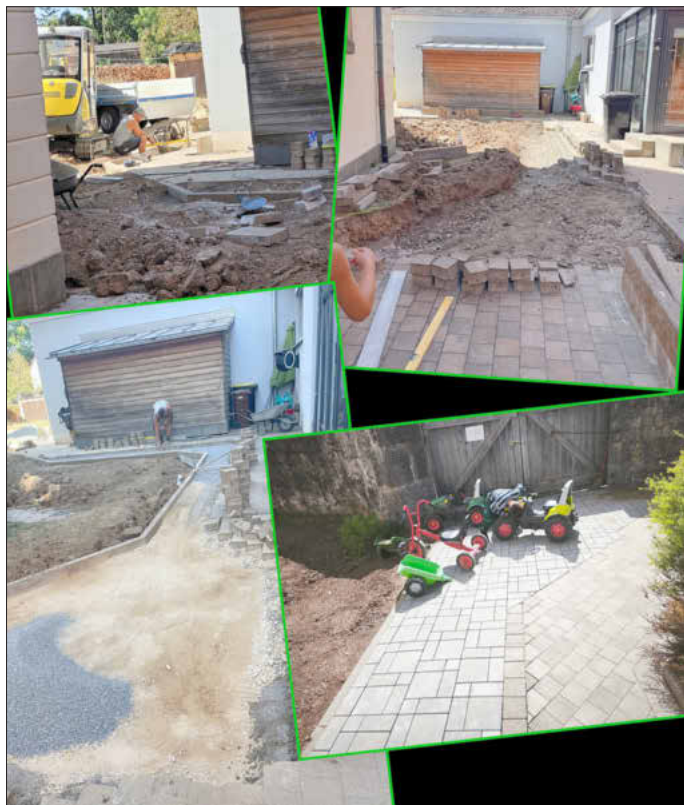
Bauarbeiten: Neue Rennstrecke
