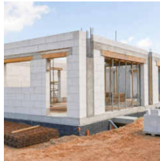
Rohbau eines Massivhauses mit gemauerten Außenwänden, Betondecke und vorbereiteten Fensteröffnungen.
