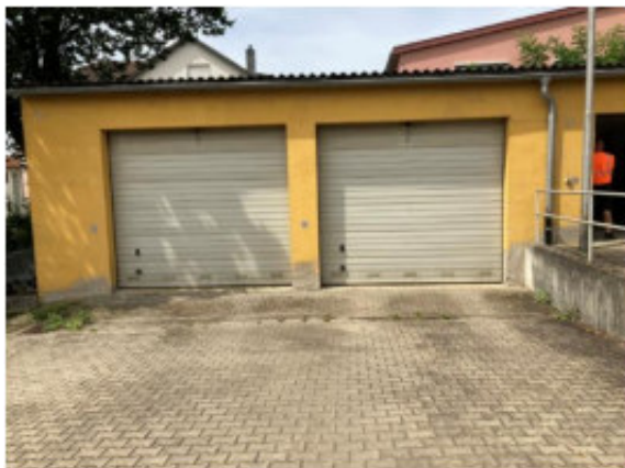
Garagenteil, tiefer liegend
