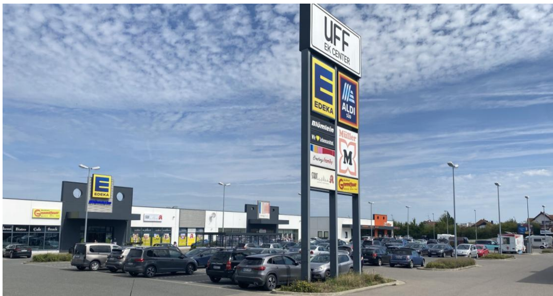
Abbildung 13: Die FMA Ansbacher Straße im südlichen Teil Uffenheims
